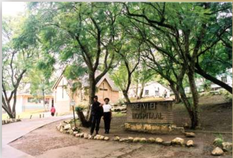
Rietvlei Hospital (“Hospitaal”)
